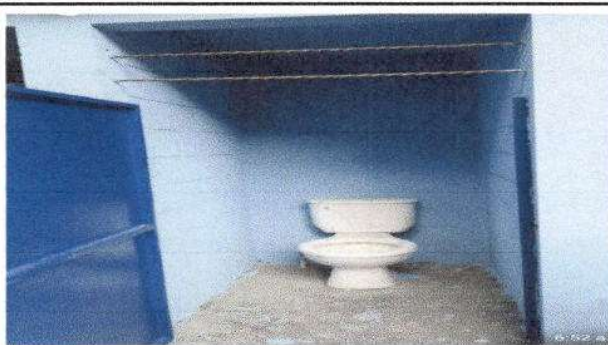
Foto 5: Sustitución de inodoro en área de baños
