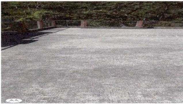
Foto 1: Impermealización de losa de patio en el Establecimiento
