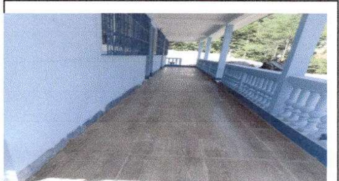
Foto 4: Sustitución de piso de cemento Líquido por piso de concreto en el corredor del Establecimiento.
