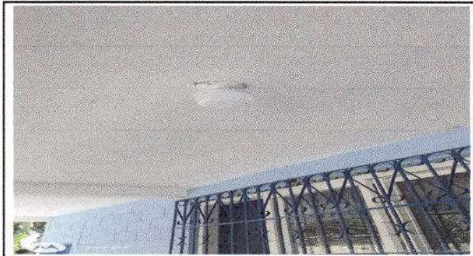
Foto7: Sustitución de Lámparas Tipo Led en Aulas
