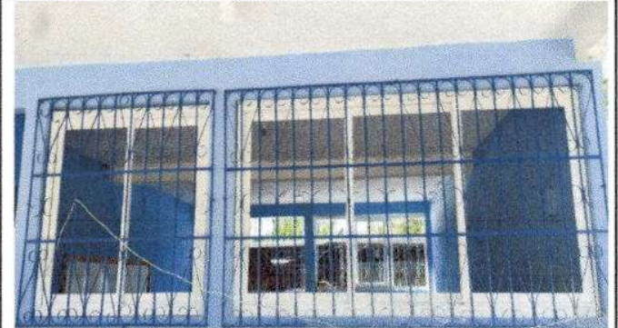
Foto 2: Sustitución de vidrios en aulas del Establecimiento
