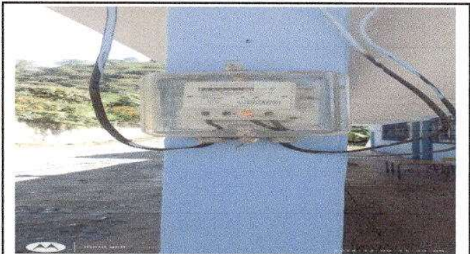
Foto 8: Reparación de Cableado Eléctrico en el Establecimiento
